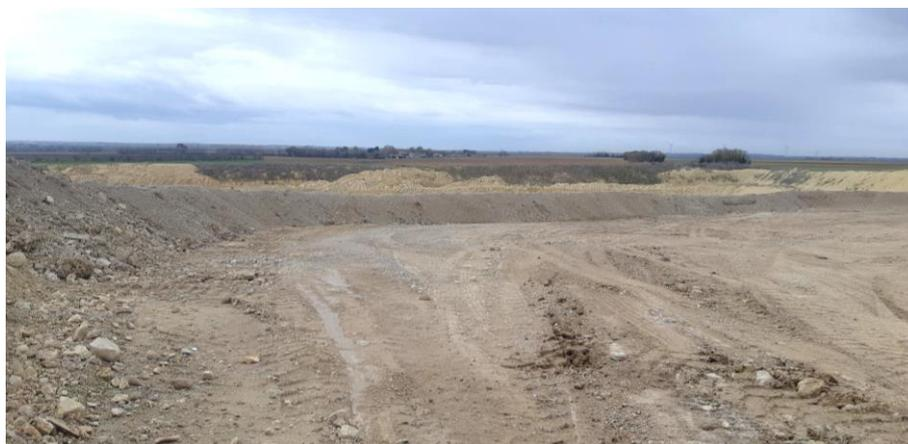
Figure 16 : exemple de merlon de sécurité en place
